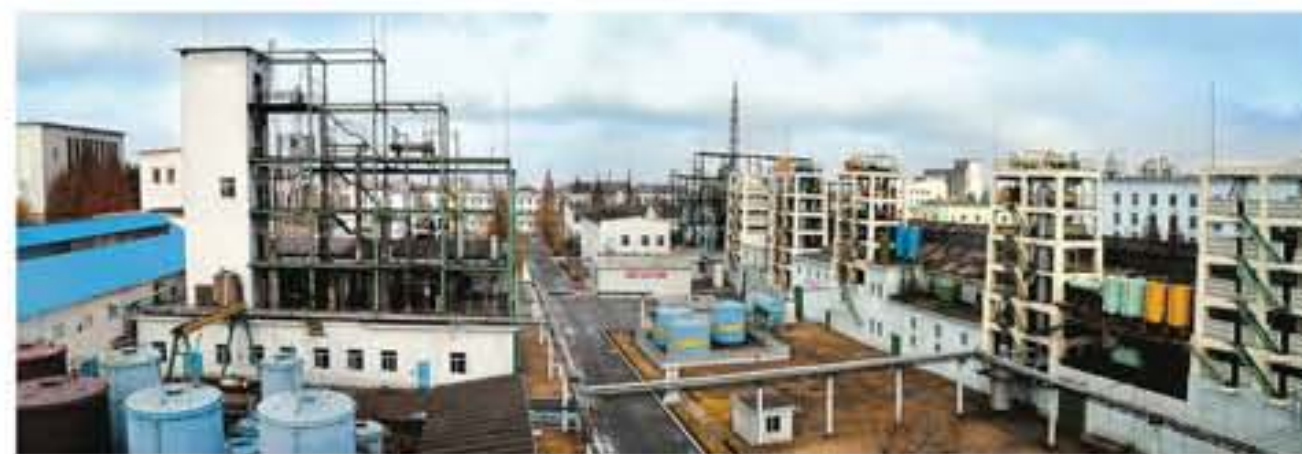
비날론공업의 주체화, 현대화가 높은 수준에서 실현된 2.8비날론련합기업소 February 8 Vinalon Complex put vinalon industry on a Juche-oriented and modern footing at a higher level
